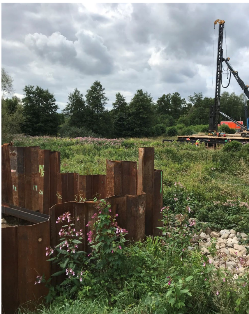
Jättebalsamin intill ett bygge
